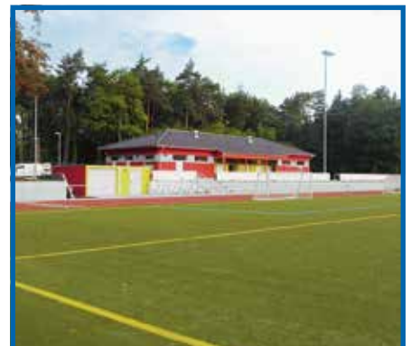
Sportplatzsanierung im Juli
