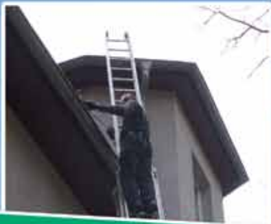
Dach- und Dachrinnenreinigung
