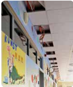
Lauter Kabel: in der Schule wird die Alarmanlage modernisiert.
