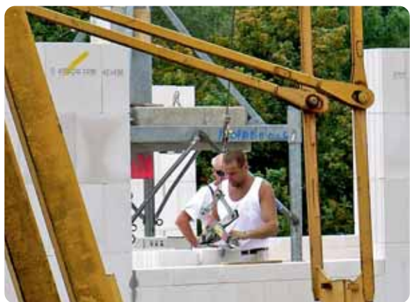
Noch wird fleißig am Gebäude gewerkelt.
