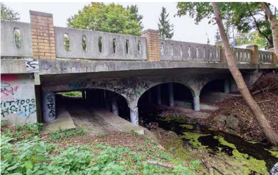
Wird im Frühjahr 2022 für mehr als ein Jahr vollgesperrt: die Brücke an der Glienicker Ortsgrenze zu Schildow
