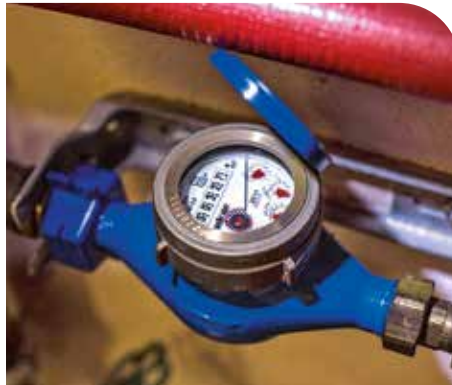
Aufgepasst: Gartenwasserzähler, die im Jahr 2015 geeicht wurden, müssen gegen ein neues Modell ausgetauscht werden.
