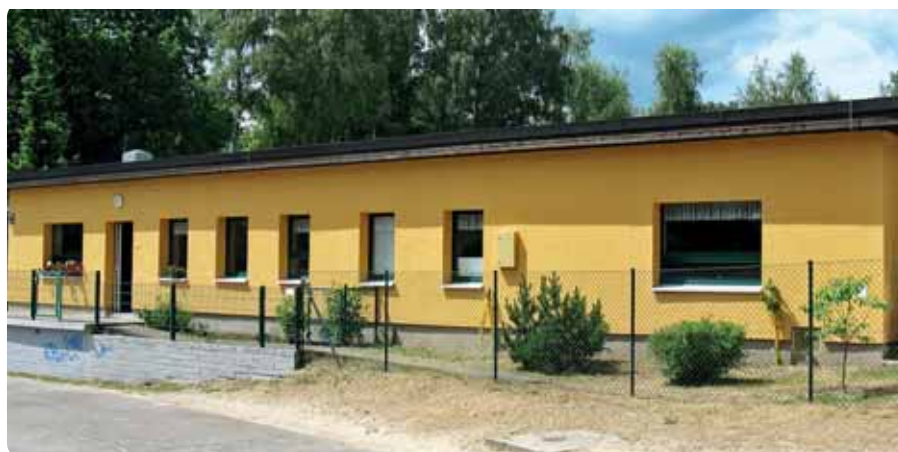
Die Kita „Burattino“ wird noch 2009 saniert.
