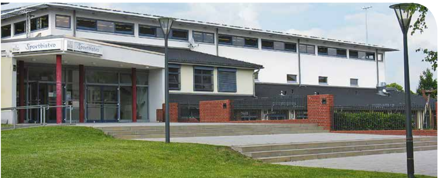
Versäumnisse in der Vergangenheit: Die Dreifeldhalle erfüllt nicht die brandschutz- und sicherheitstechnischen Auflagen.
