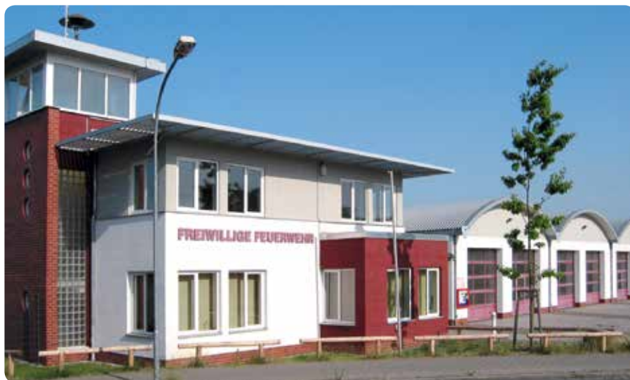
Teurer als gedacht: der Feuerwehr-Anbau
