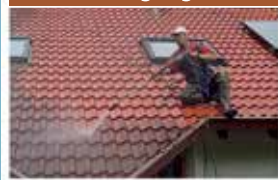
Dach- / Dachrinnen- reinigung
