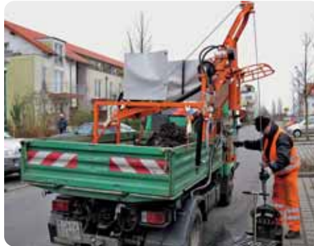
Auch die Reinigung der Laubkörbe unter Gullydeckeln gehört zu den Aufgaben des Bauhofes: Hier ist Matthias Seifert beim Einsatz im Wohngebiet Sonnengarten.
