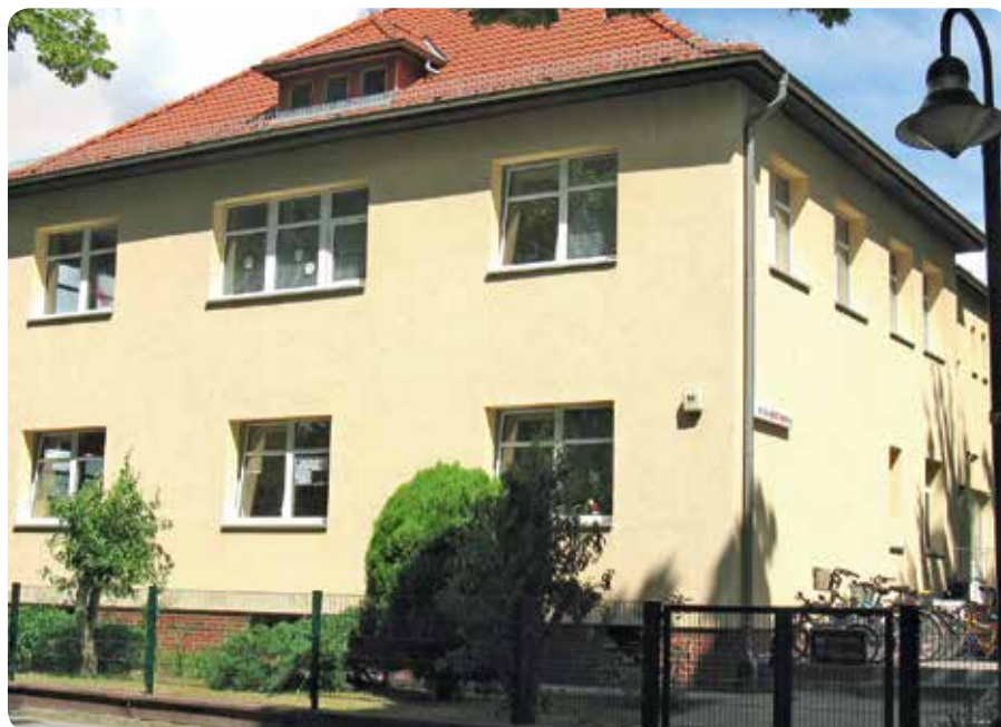
Umbauarbeiten in der Kita Mischka
