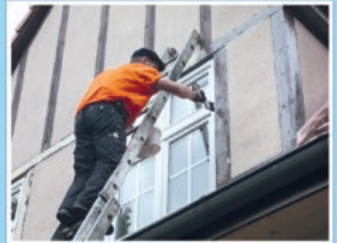
Dachkasten- /Oberflächenbehandlung
