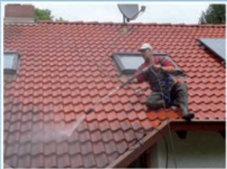
Dach- und Dachrinnenreinigung
