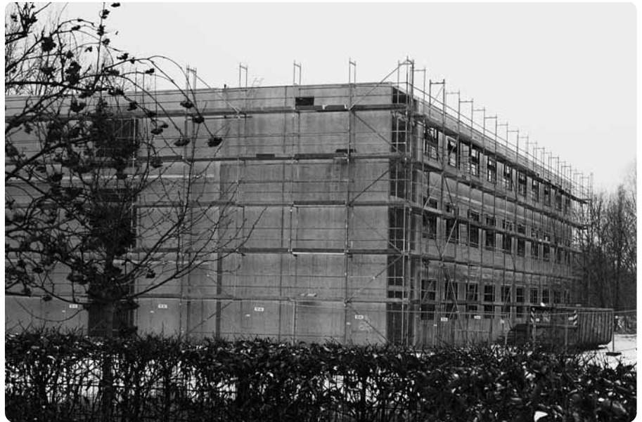
Der Gymnasiumsbaubau macht Fortschritte.
