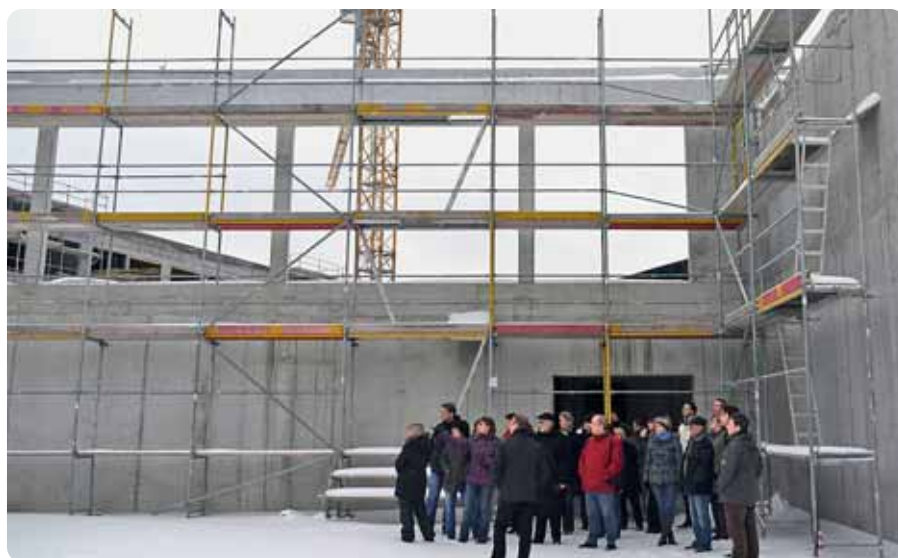
Der künftigen Sporthalle fehlt noch das Dach.
