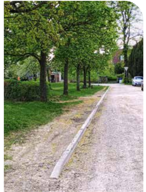
Soll mit Betonsteinpflaster zu einem sicheren Gehweg ausgebaut werden: der Trampelpfad links des Sportplatzweges
