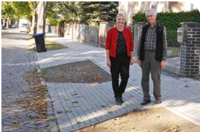
Schauten sich den neuen Gehweg in der Heinrich-Heine-Straße an: Bauamtsleiter Peter Staamann (r.) und Ulrike Stöwhas vom zuständigen Planungsbüro
