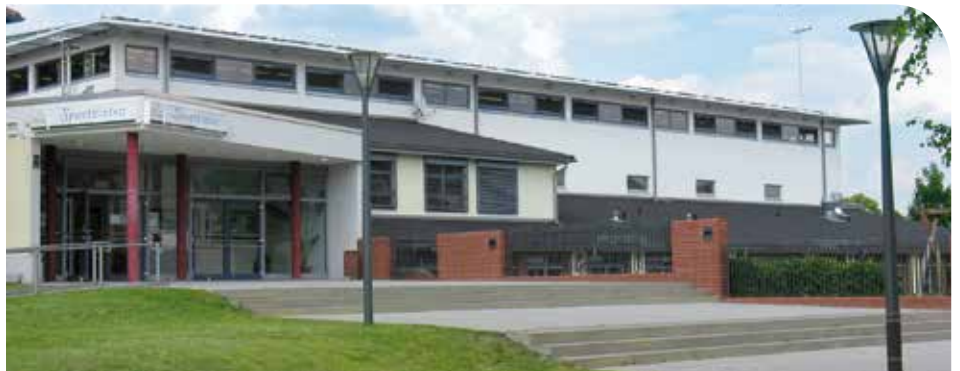
Soll Sport- und Veranstaltungsstätte werden: die Dreifeldhalle
