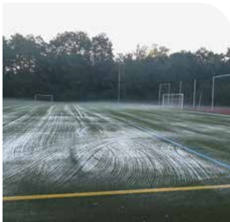
Neue Granulat-Sand-Mischung: Die ausführende Firma verfüllte 40 Tonnen des Materials auf dem Sportplatz Bieselheide
