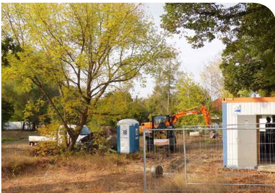
Bagger auf dem Grundstück an der Karl-Marx-Straße.
