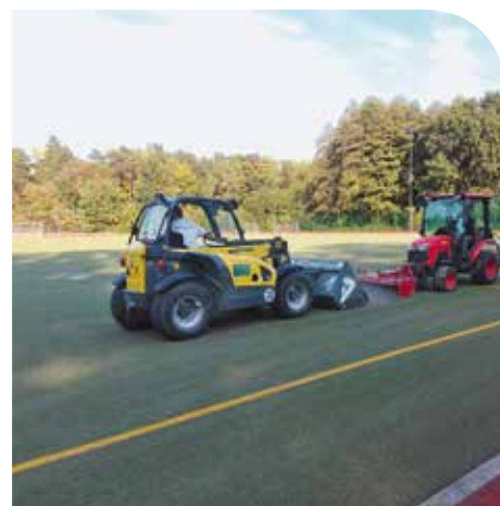
Viel Arbeit: Innerhalb von einer Woche war die Reparatur des Rasens erledigt.
