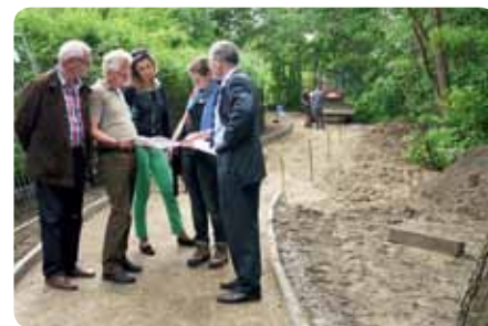
Gemeindevorsteher Martin Beyer, Bauamtsleiter Peter Staamann, Tiefbau-Mitarbeiterin Kathrin Nickel, Jennifer Zelt vom Büro Wallmann und Bürgermeister Oberlack machten sich vor Ort ein Bild von der Wanderweg-Baustelle.
