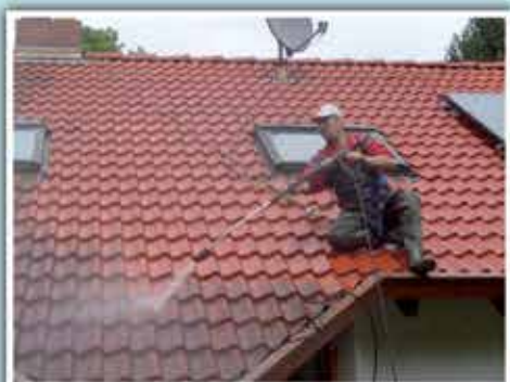
Dach- und Dachrinnenreinigung
