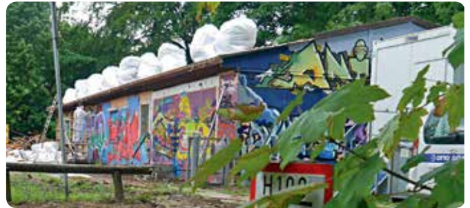
Der Abriss des Treffs dauerte mehrere Tage.
