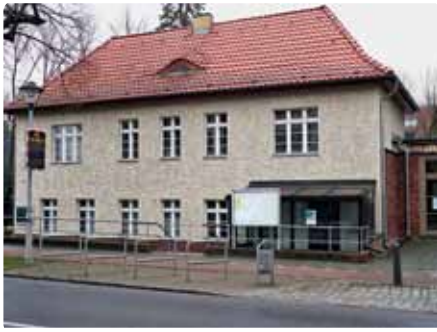
Einstimmig beschloss die GVT die Sanierung des Gebäudes in der Hauptstraße 20.
