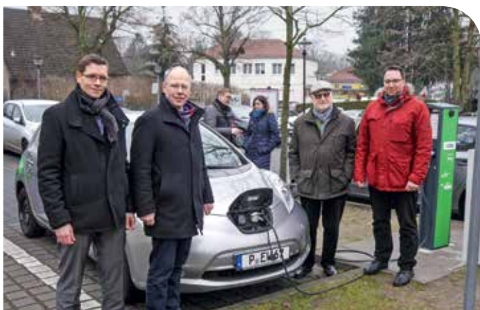
Nahmen die neue Elektrotankstelle in Betrieb: (v.l.) Hendrik Hess, Referent für Kommunalmanagement der E.DIS, Bürgermeister Dr. Hans G. Oberlack, Martin Beyer, Vorsitzender der Gemeindevertretung, und Sandy Schramm von der E.DIS Netz GmbH
