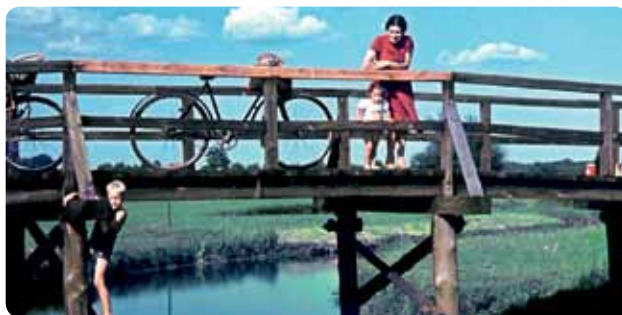
Brücke über das Tegeler Fließ von Glienicke nach Lübars am sogenannten Eichwerder Steg (1943) Foto: privat
