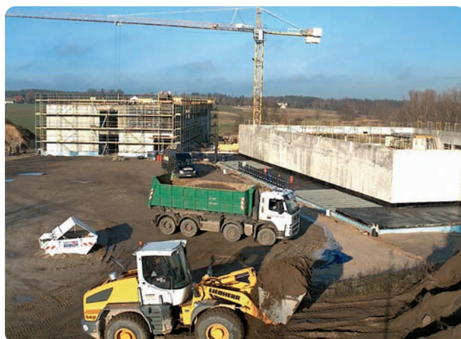
Im Oktober soll die Schule in Mühlenbeck fertig sein.
