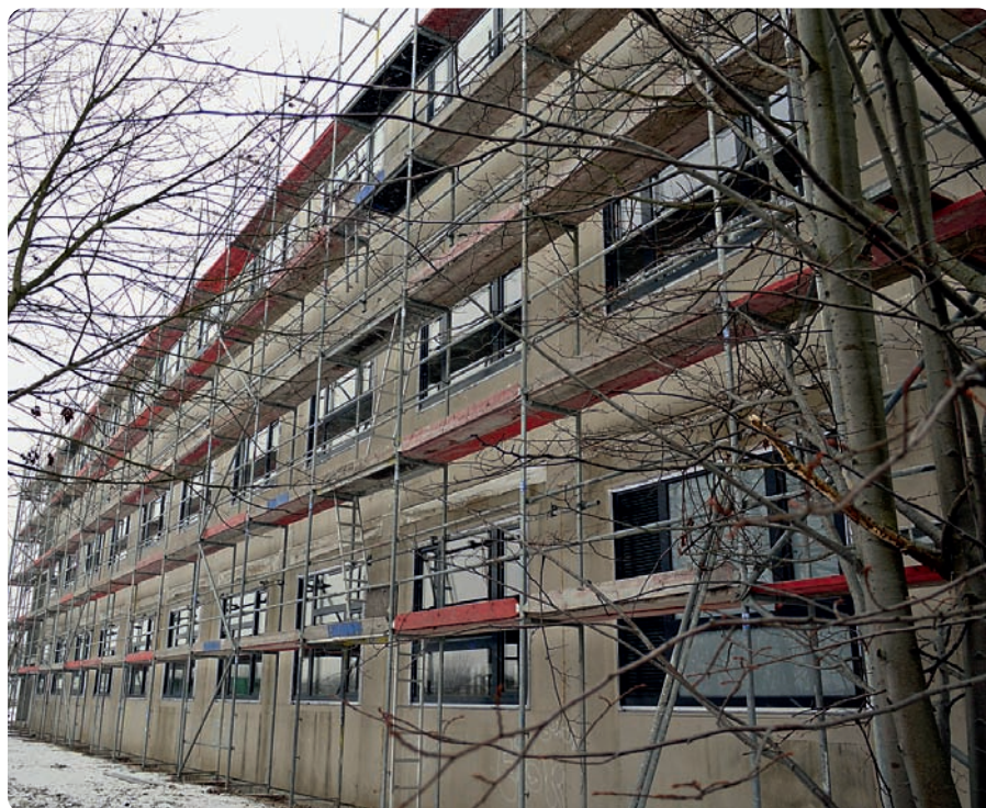
Neues Gymnasium: Die Fenster sind drin.
