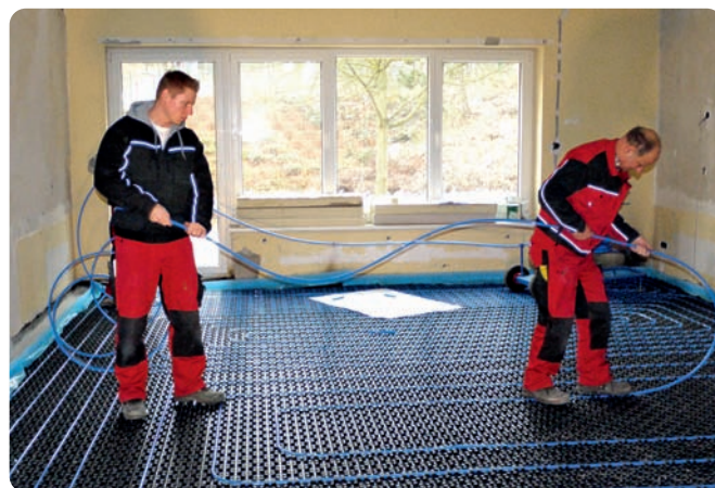
Arbeiter der Haustechnik-Firma Starke aus Falkensee beim Verlegen der Fußbodenheizung in einem Gruppenraum.
