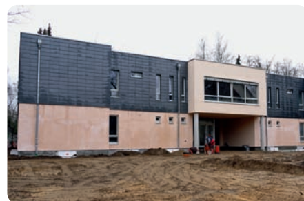
Die Hülle der Rathauseserweiterung ist schon fast fertig.
