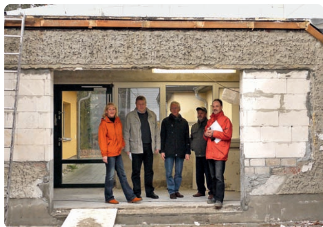
Die Baustelle besichtigten Kitaleiterin Simone Eichhorn, Bürgermeister Joachim Bienert, Bauamtsleiter Peter Staamann, Architekt Dieter Bortchen und Hochbau-Verantwortlicher Lutz Miethe.
