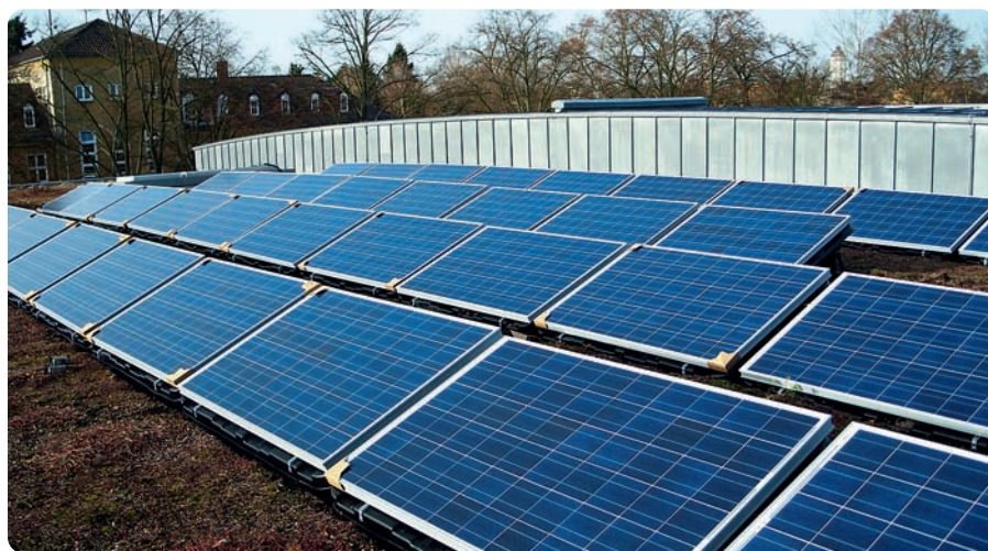
Die Kollegen aus Hohen Neuendorf haben es schon geschafft: Auf dem Dach der Mehrzweckhalle ist die Anlage installiert. Foto: privat
