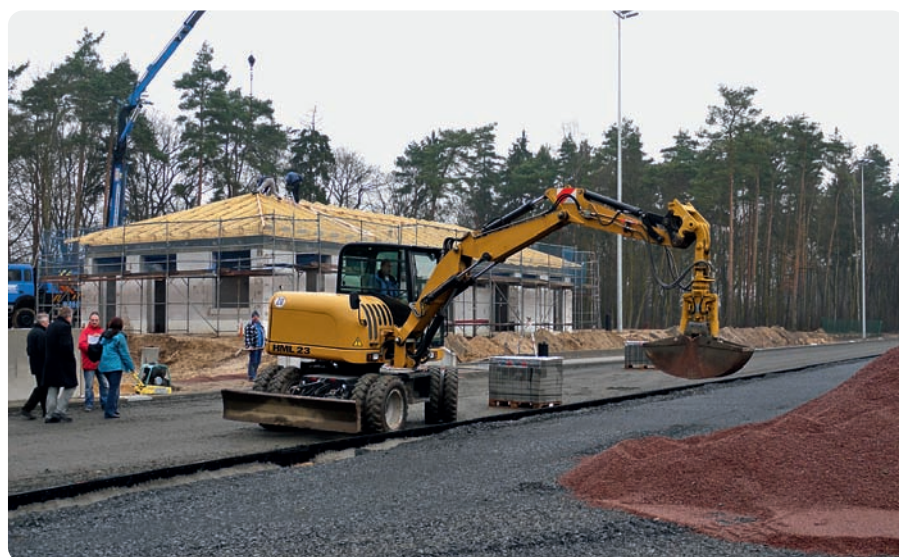
Die Bauarbeiten am Funktionalgebäude liefen noch im Dezember auf Hochtouren.
