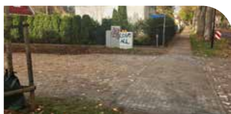
Barrierefreie Querung an der Lessingstraße
