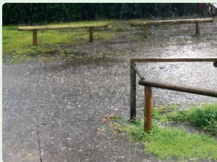
In einigen Straßen im Ort kommt es bei starkem Regen regelrecht zur Überschwemmung. Foto: Archiv
