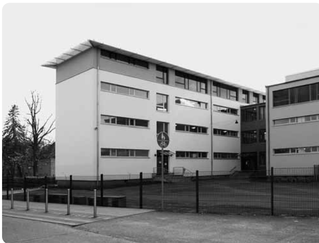
Hier soll der Hortneubau entstehen
