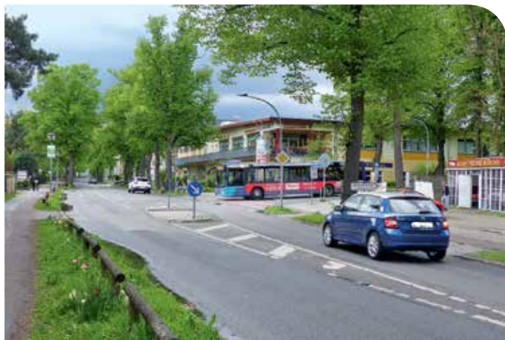
Hier werden demnächst neue Schmutzwasserleitungen verlegt.
