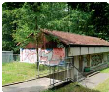
Das zentrale Abwasserpumpwerk.
