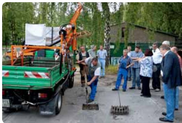
Anschaulich gezeigt: Auch um die Reinigung von Regenwassereinläufen kümmert sich der Bauhof.
