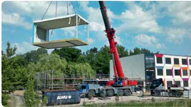
Das Untergeschoss des fertig gestellten 3. Bauabschnitts des Neuen Gymnasiums bietet nach den Sommerferien Platz für weitere Klassenräume. Foto: B. Gaffling
