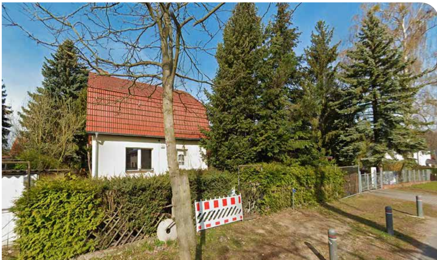
Trotz Teilsanierung herrscht Leerstand: das gemeindeeigene Objekt in der Feldstraße 44
