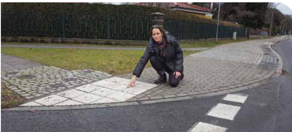
Für Geh- und Sehbehinderte gleichermaßen angelegt: Die Gehwege entlang der frisch sanierten L171 in Bergfelde
