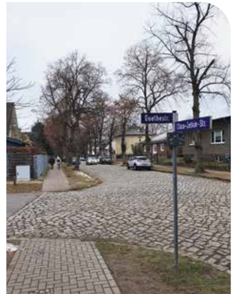
Einer von vielen Vorschlägen zum barrierefreien Umbau: Die Überquerung Clara-Zetkin-Straße/Goethestraße, wo die Asphaltdecke vor dem kreuzenden Gehweg endet.
