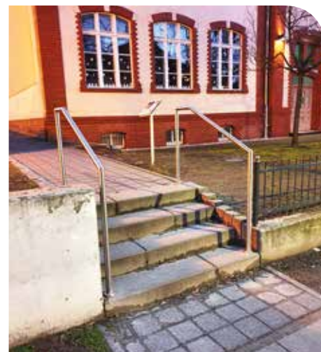
Zügig umgesetzt hat die Gemeindeverwaltung unseren Antrag zur Installation eines Handlaufs an den Stufen zur Dreifeldhalle. Wir sagen „danke“! Foto: Uwe Klein
