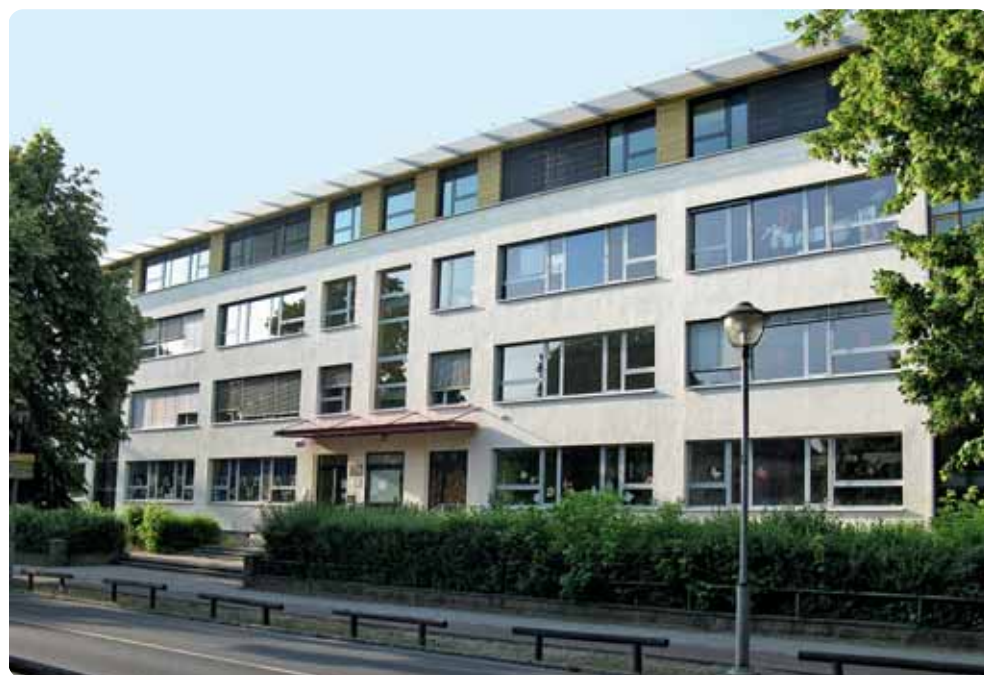
Auf dem Dach der Grundschule ist eine Solaranlage denkbar.
