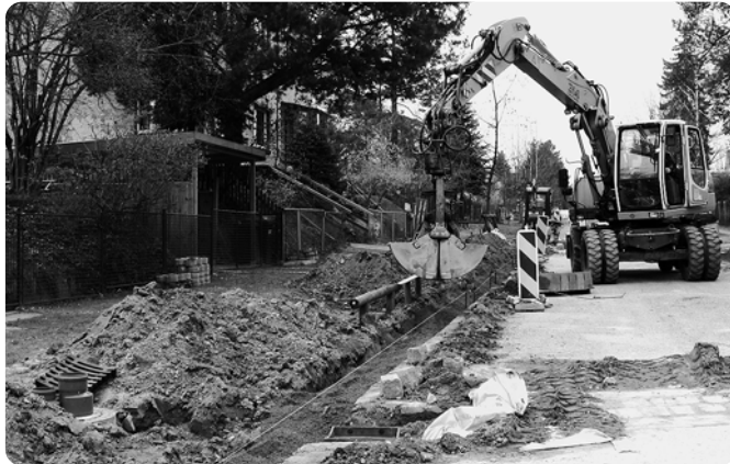
Die Heinrich-Heine-Straße hat nun ein System zur Regenentwässerung.
