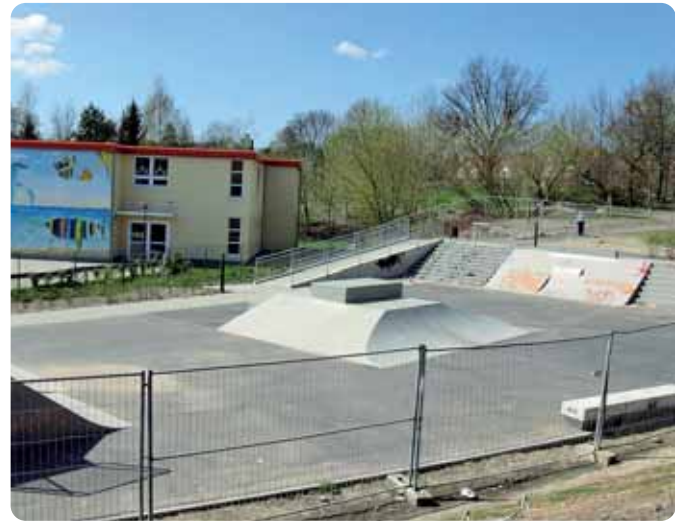
Noch in diesem Monat werden die Bauzäune an der Skateranlage verschwinden.
