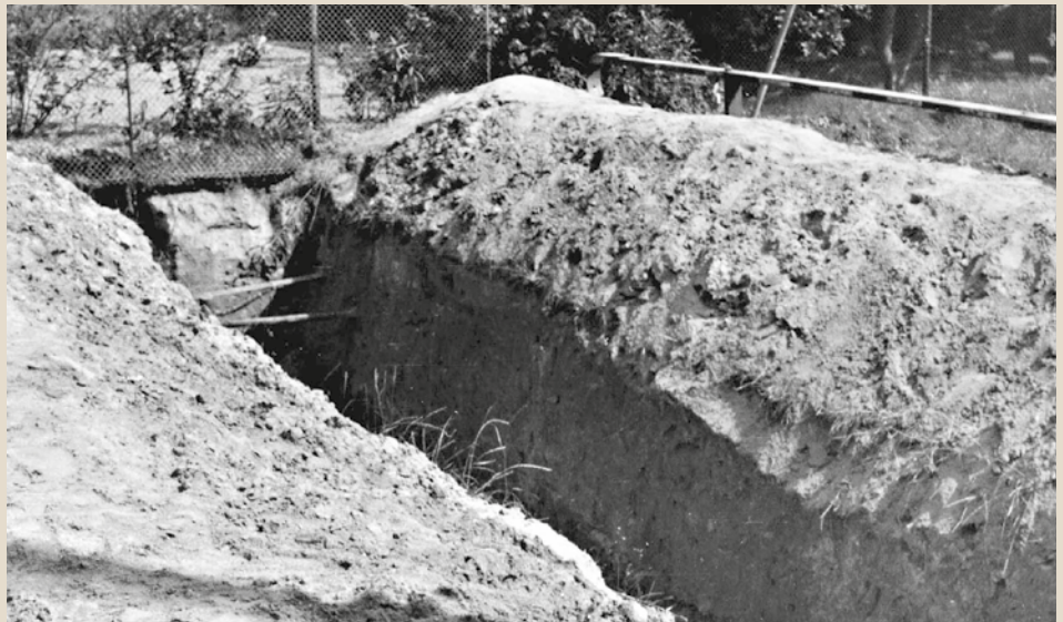
Bild 1: Sperrgraben in der Joachimstraße (Juni 1952)
