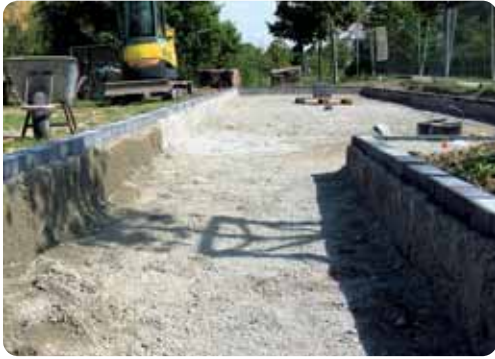
Anfang September war die Bouleanlage noch im Bau.
