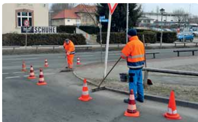
Auch nach der Schneeschmelze hatte der Bauhof viel zu tun, hier beim Einkehren des Splitts.
