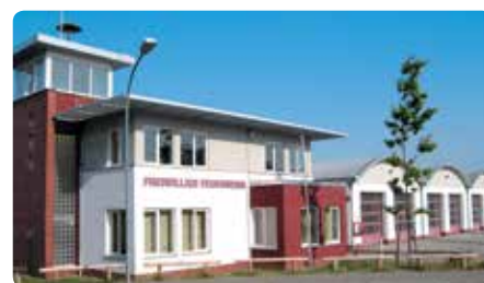
Erhält einen Erweiterungsbau: das Feuerwehrgebäude in der Hattwichstraße
