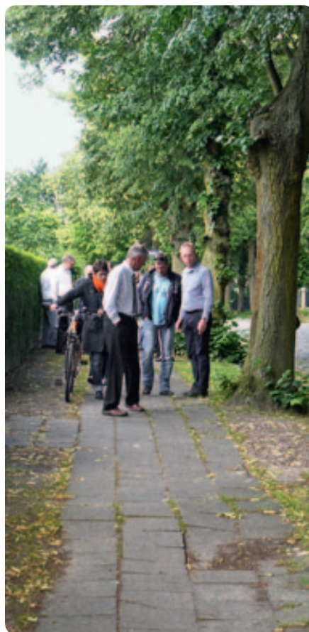
Bei einem Vor-Ort-Termin begutachtete der Ausschuss den defekten Gehweg in der Clara-Zetkin-Straße.
