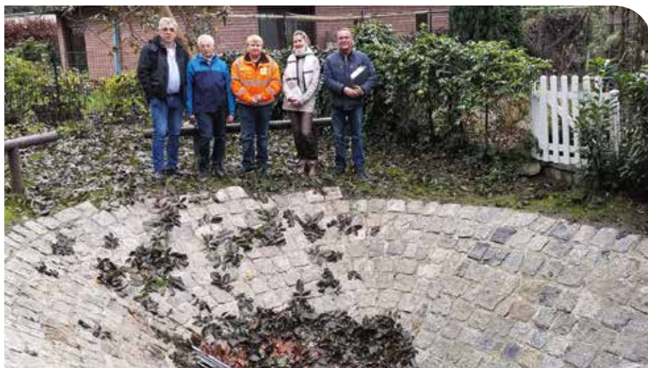
Begutachteten das neue Auslaufbauwerk direkt am Springluchgraben: (v.l.) Uwe Klein, Vorsitzender der Gemeindevertretung, Bauamtsleiter Peter Staamann, Stefan Hörster (Gutsche Tiefbau GmbH), Kathrin Nickel, stellvertretende Bauamtsleiterin und Ingenieur Christoph Bäske vom zuständigen Planungsbüro Dr. Löber
