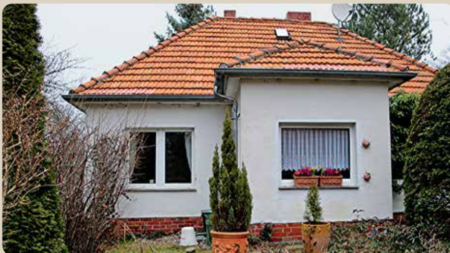
Otto Fröbels ehemalige Laube. Seit den 1950er Jahren ist sie ein Massivhaus.
