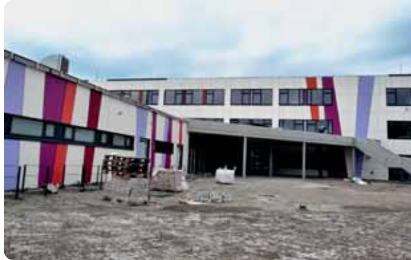
Die Schule in Mühlenbeck ist nahezu fertig gestellt.
