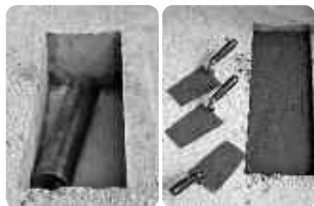
Links die Rolle mit Erinnerungsstücken. Rechts: Nachmischen war nötig: Die erste Lage Beton reichte nicht ganz aus, um das Loch im Fundament zu füllen.
