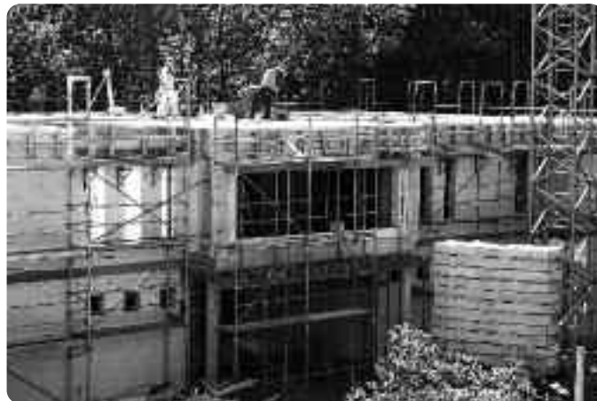
Im ersten Quartal 2010 ist die Rathausenerweiterung fertig. Fotos(3): Pelz
