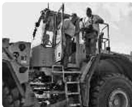
Der Bürgermeister packte an und half bei den Bauarbeiten mit.
