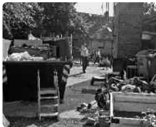
Bevor es mit der Sanierung losging, wurde kräftig ausgemistet.
