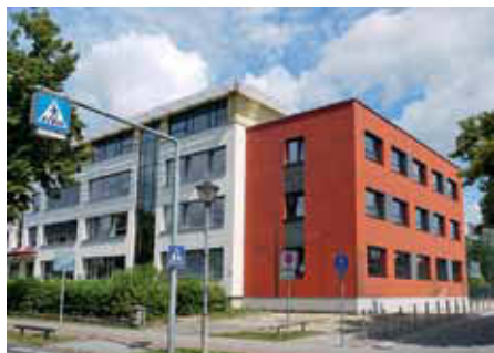
Der Hortanbau samt Kinderbibliothek ist fertig. Bauabnahme war im Juni.
